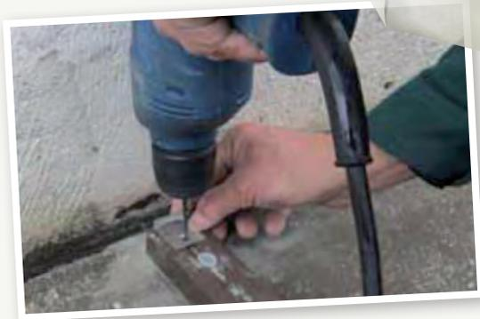
Wenn 2 WPC Dielen in Längsrichtung aneinander verlegt werden, ist die entsprechende Unterkonstruktion für beide WPC Dielen zu verlegen. Beide Enden sind separat mit den Befestigungsclips zu montieren.
